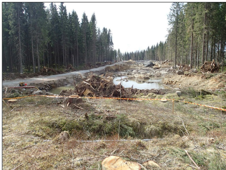
Rännihaudan sijainti tietyömaa-alueella.
